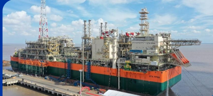
N999浮式天然气储卸油平台 N999浮体式生産貯蔵および荷降ろしプラットフォーム
