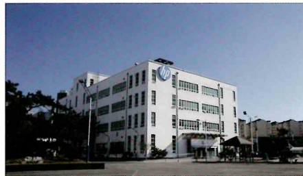
アメリカ HP は威海で全世界のレーザープリンターの生産基地を建設した。
