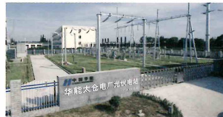
华能太仓电厂光伏电站项目
