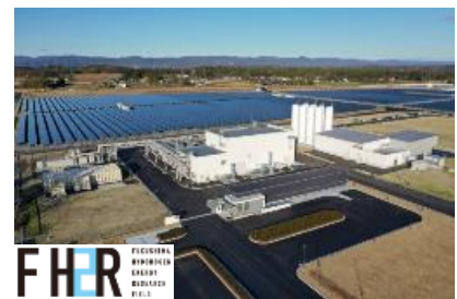
FHR 出典：東芝エネルギーシステムズ（株） 太陽光発電で作った電気を 用いた水素製造の実証
