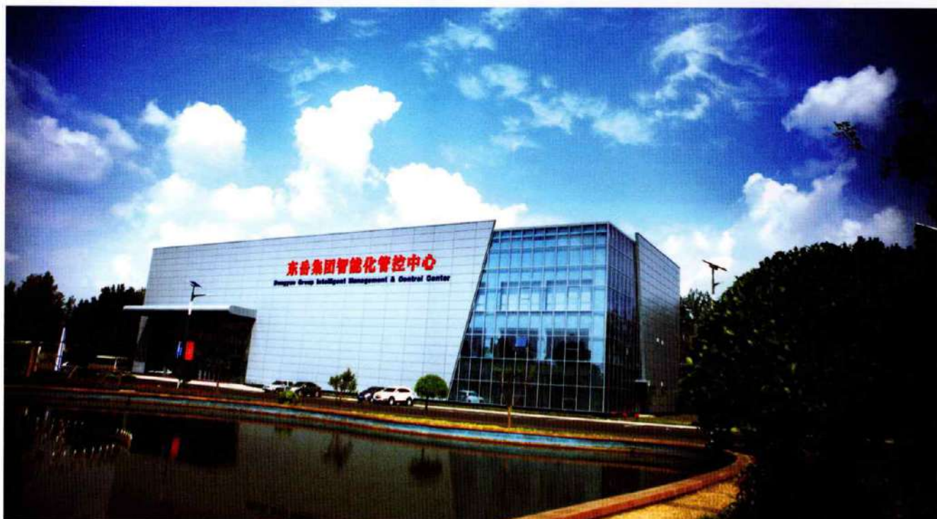
東岳知能化管理制御センター
