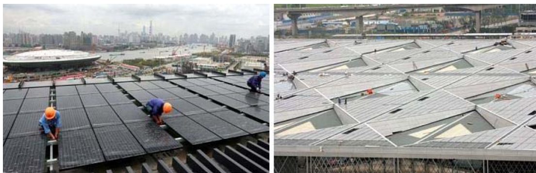
上海万博における太陽光発電システム（左は工事中、右は完成後）
