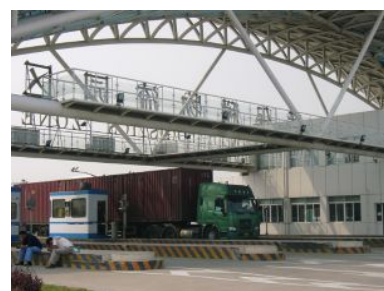
上海外高橋物流園区の貨物ゲート
